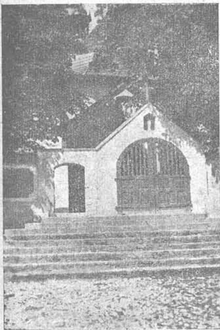
Niegowa — kościół od strony wejścia.
