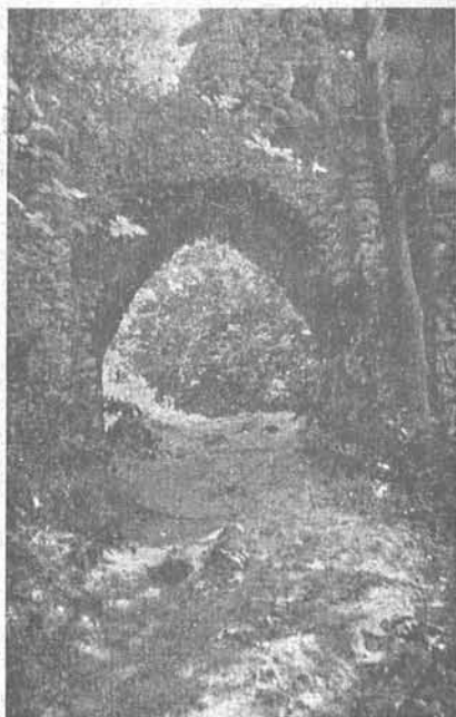
Smoleń — brama wjazdowa na zamek.
