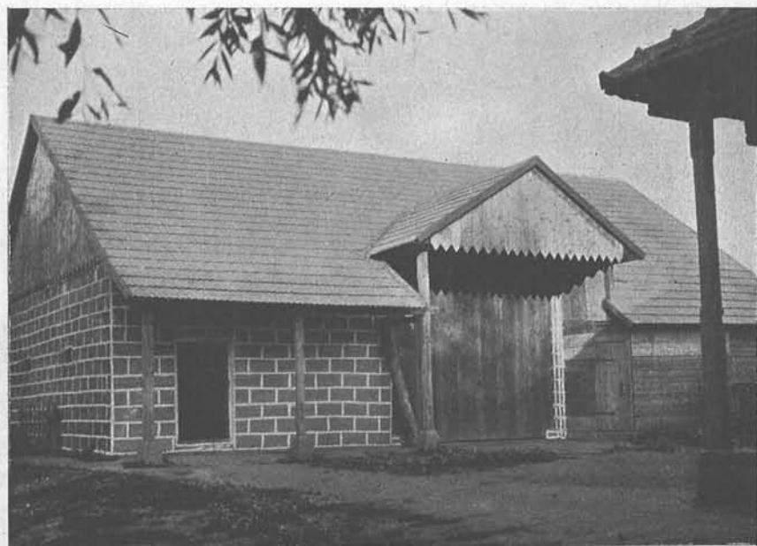
Fot. 4. Stodoła zbudowana z pustaków piaskowo-cementowych wyrabianych odrębnie, na miejscu. Wieś Bieńkowice (pow. Bochnia) nizina Nadwiślańska.
